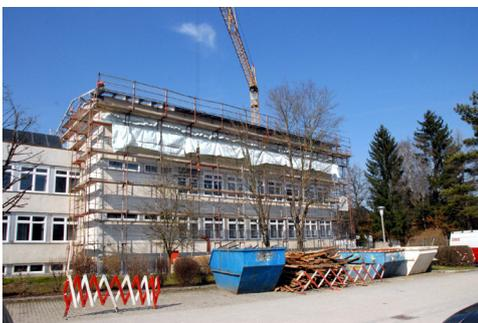
Mitte März war Start der letzten Bauetappe der Volksschulsanierung. Begonnen wird mit der Erneuerung und Isolierung des Daches. In weiterer Folge die Isolierung der Außenwände und die Anbringung des Sonnenschutzes. Mit Ende der Sommerferien sollte das Projekt endgültig fertig gestellt sein.
