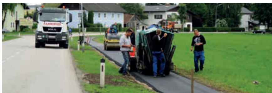
An der Bushaltestelle, beim sanierten Gehweg, wird das Wartehaus errichtet.
